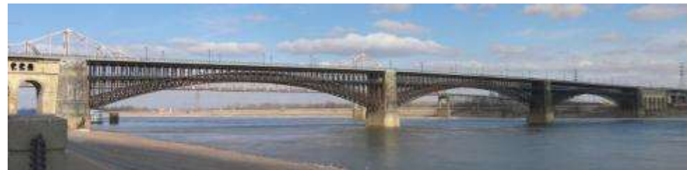
Eads Bridge, St. Luis (Missouri) Brücke über den Mississippi (Bau: 1866-1876)
