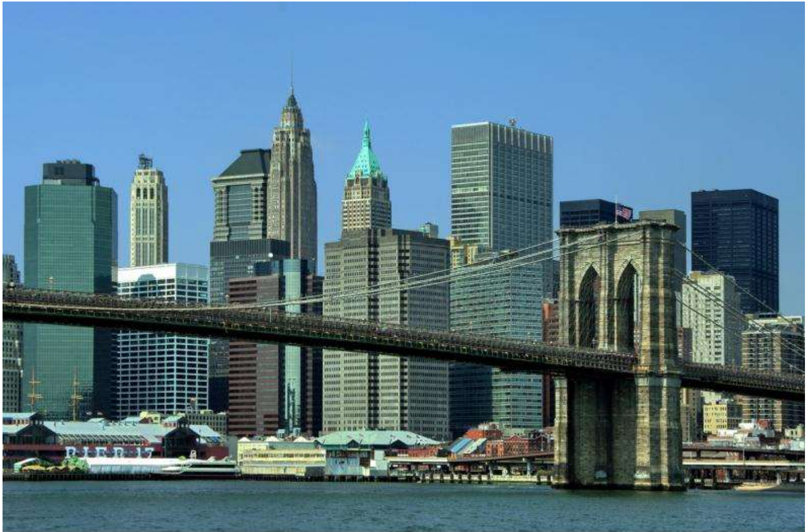
Bau: 1865-1883 Johann (John) August Roebling, später Washington R., dann Emily Warren R.
